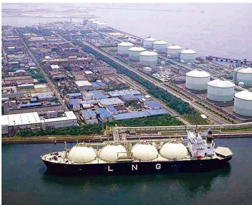
Tanker na LNG terminalu
