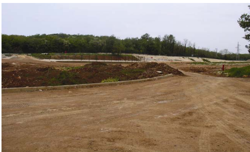
Sanacija u tijeku na odlagalištu Košambra u Poreču
