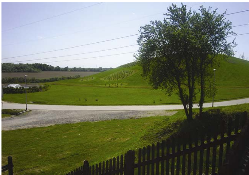
Sanirano odlagalište otpada Mraclinska Dubrava , Mraclin
